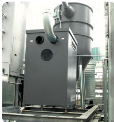
Filtereinheit mit Explosionsschutz
