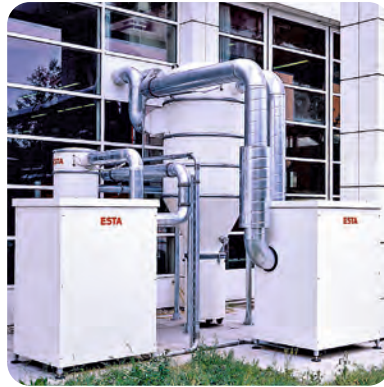
Absauganlage in Sonderlackierung im Freien aufgestellt
