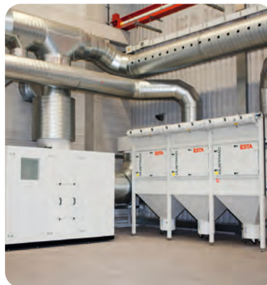
DUSTMAC Filtereinheit mit Absaug- und Zuluftventilator
