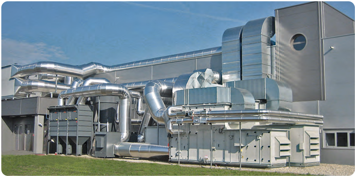
Individuelles Anlagenkonzept mit DUSTMAC-Filtereinheiten in der Schuhindustrie
