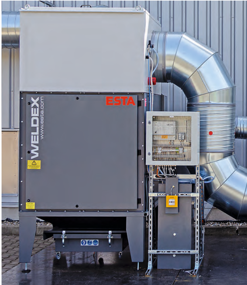
Zentrale Filtereinheit mit Löschanlage in einem Schweißrauch-Absaugsystem
