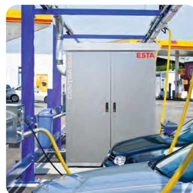
Witterungsbeständiges Gehäuse zur Außenaufstellung
