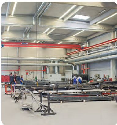
Produktionshalle mit 24 Schweißarbeitsplätzen
