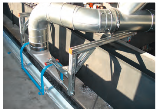
Saugschlitzkanal zur Absaugung von Metallspänen
